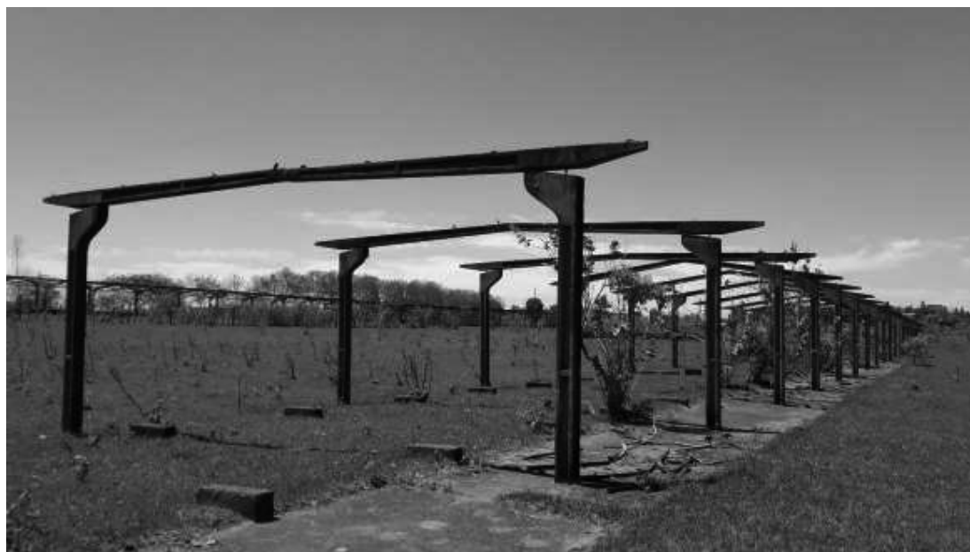
Figura 4 Antigas instalações abandonadas. Fonte: Os autores (2019)
