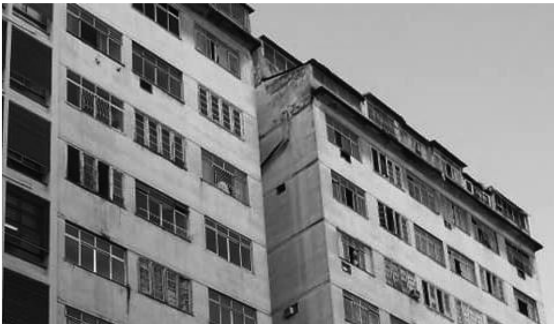
Figura 1. Vista geral do Prédio da Caixa. Foto: Guina Araújo Ramos.
